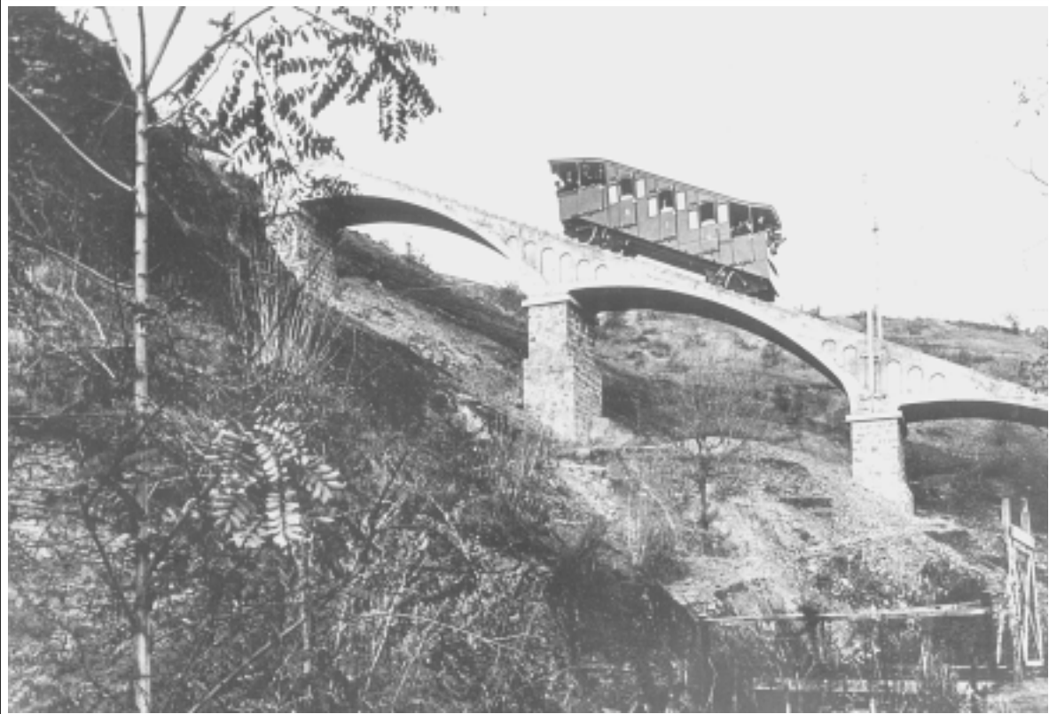
Construcción del funicular, 1925.
