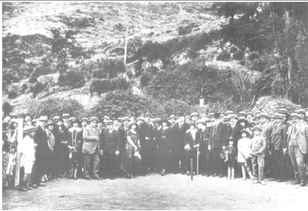
Colocación de la primera piedra del funicular, 1923.
