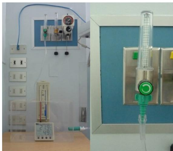
**Figura 2.** Instalación de inyector de oxigenoterapia sin sistema humidificador.
