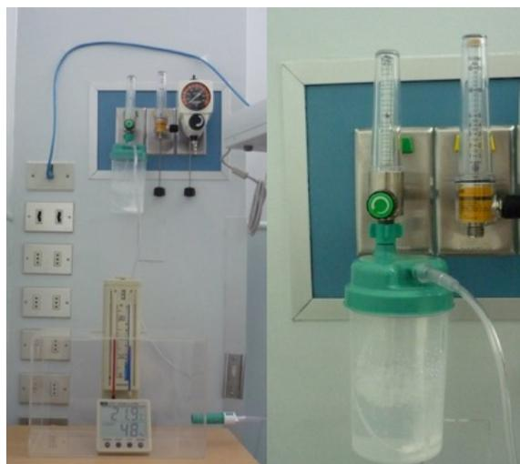
**Figura 3.** Instalación de inyector de oxigenoterapia con sistema humidificador.
