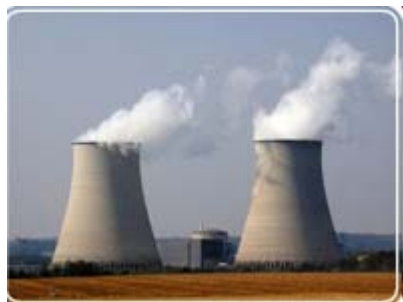
generación de energía
