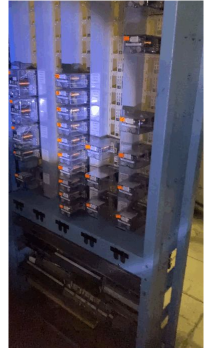
Bastidor de señalización en Estación Manquehue
