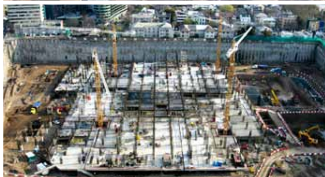
Construcción proyecto Costanera Center
