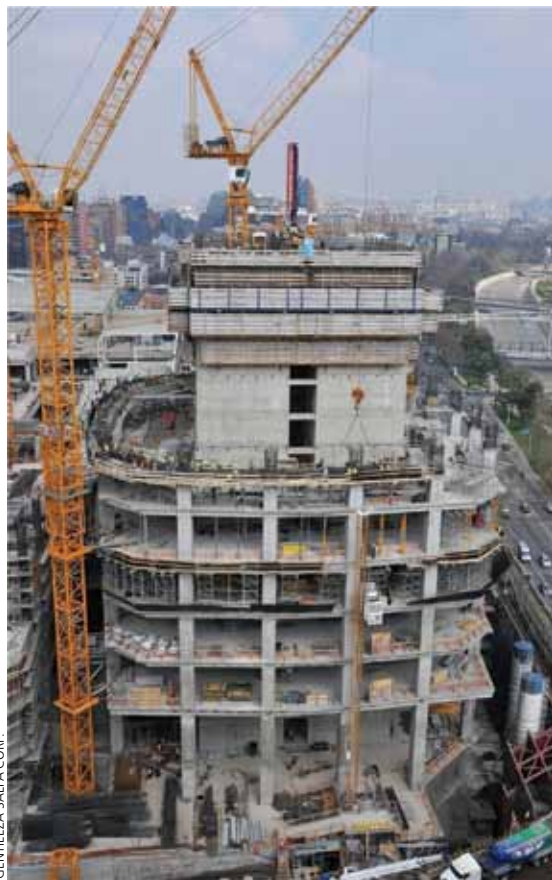
La construcción del núcleo se realizó con moldajes autotrepantes que funcionan con sistemas hidráulicos controlados remotamente por un operador quien los eleva a medida que se completa cada sección.
