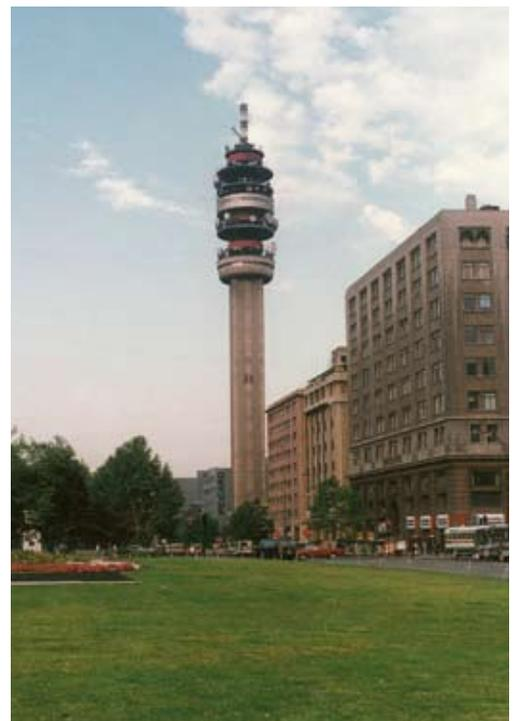
La altura de la torre se explica porque las antenas de microondas (frecuencias elevadas de radio) requieren que no exista ningún tipo de obstáculo físico delante de ellas como cerros, edificios y árboles.
