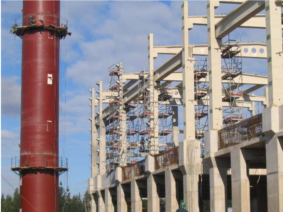
Edificio de Blanqueo Planta Celulosa Nueva Aldea. Diseño según norma sísmica chilena NCh2369of2003.
