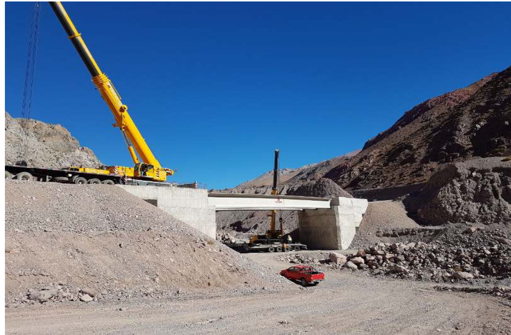
Vigas Pretensadas Paso Agua Negra – Vigas Pretensadas 70ton - La Serena – 4.900 msnm
