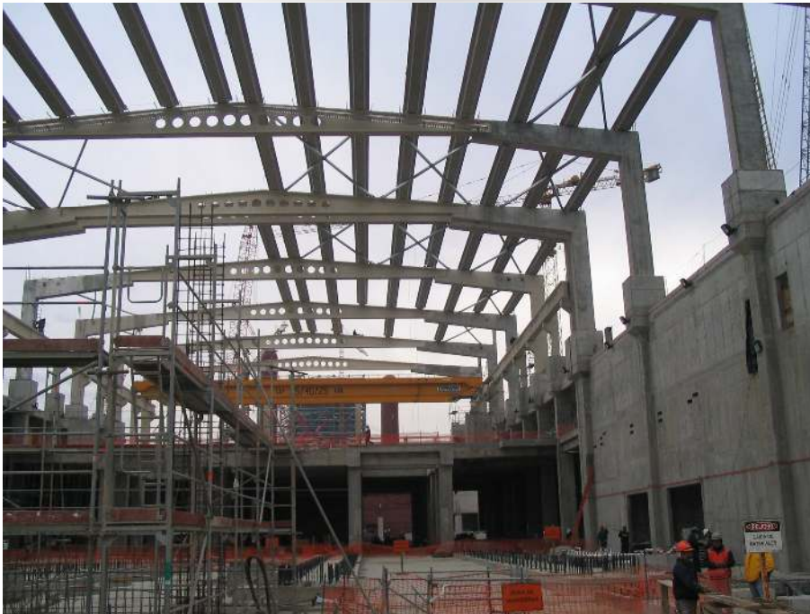
Edificio de Máquina Principal Planta Celulosa Nueva Aldea. Diseño según norma sísmica chilena NCh2369of2003
