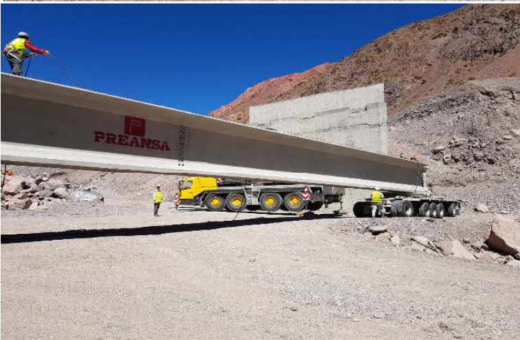
Vigas Pretensadas Paso Agua Negra – Vigas Pretensadas 70ton - La Serena – 4.900 msnm
