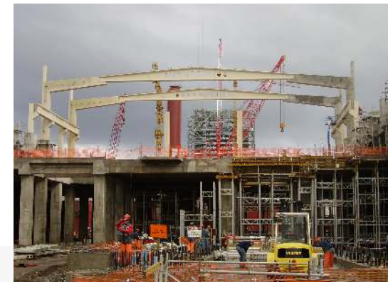
Edificio de Máquina Principal Planta Celulosa Nueva Aldea. Diseño según norma sísmica chilena NCh2369of2003
