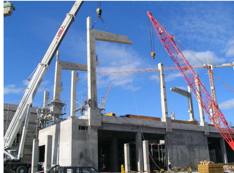
Edificio de Máquina Principal Planta Celulosa Nueva Aldea. Diseño según norma sísmica chilena NCh2369of2003
