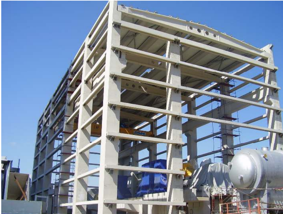
Edificio Turbogenerador Planta Celulosa Nueva Aldea. Diseño según norma sísmica chilena NCh2369of2003.
