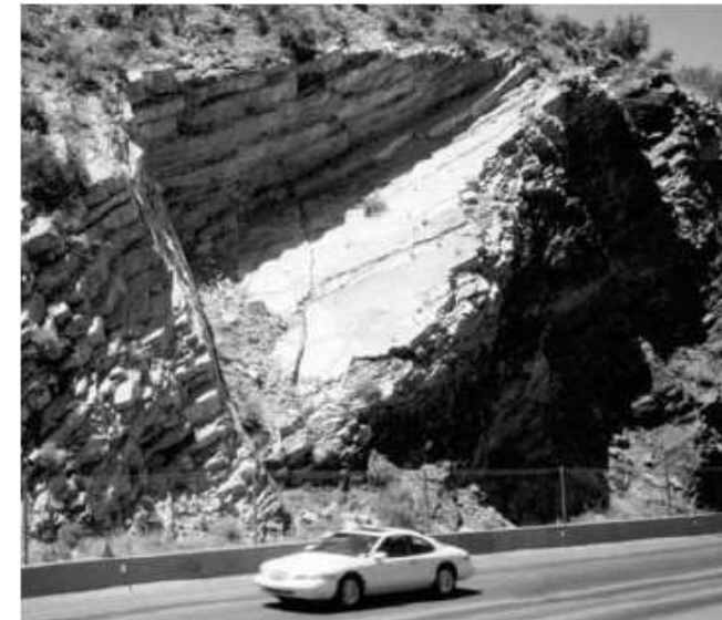
Falla por cuña (Wyllie and Mah, 2004)
