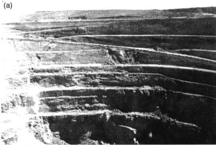
Cuña removida durante la construcción por pre-splitting de un talud en roca (Harrison and Hudson, 2001)
