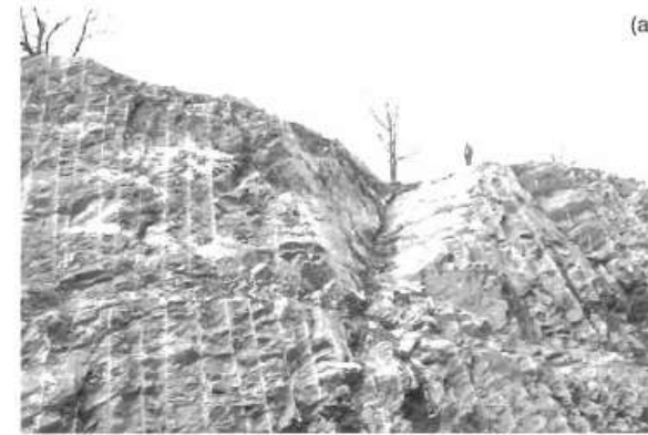
Cuña removida durante la construcción por pre-splitting de un talud en roca (Harrison and Hudson, 2001)
