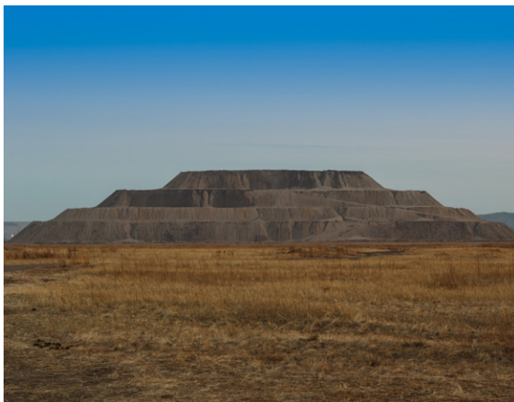
Figura 10. Ejemplo de botaderos de escoria. Fuente: Fundación Chile.
