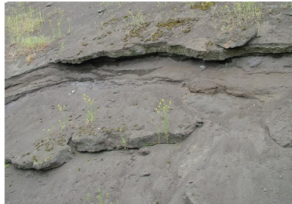
Figura 35. Hardpan o cementación en un botadero de escorias (Alemania).
