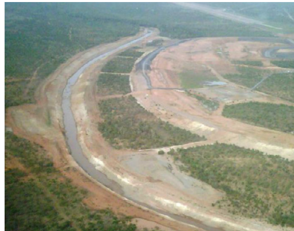
Figura 28. Desviación de un río en el entorno de una faena minera (Australia).
