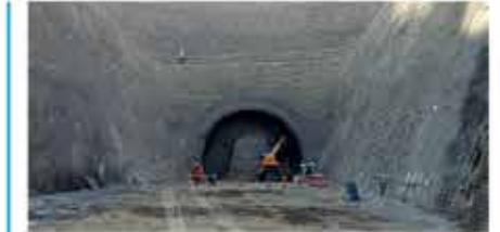
Foto: Túnel El Melón, Región de Valparaíso.
