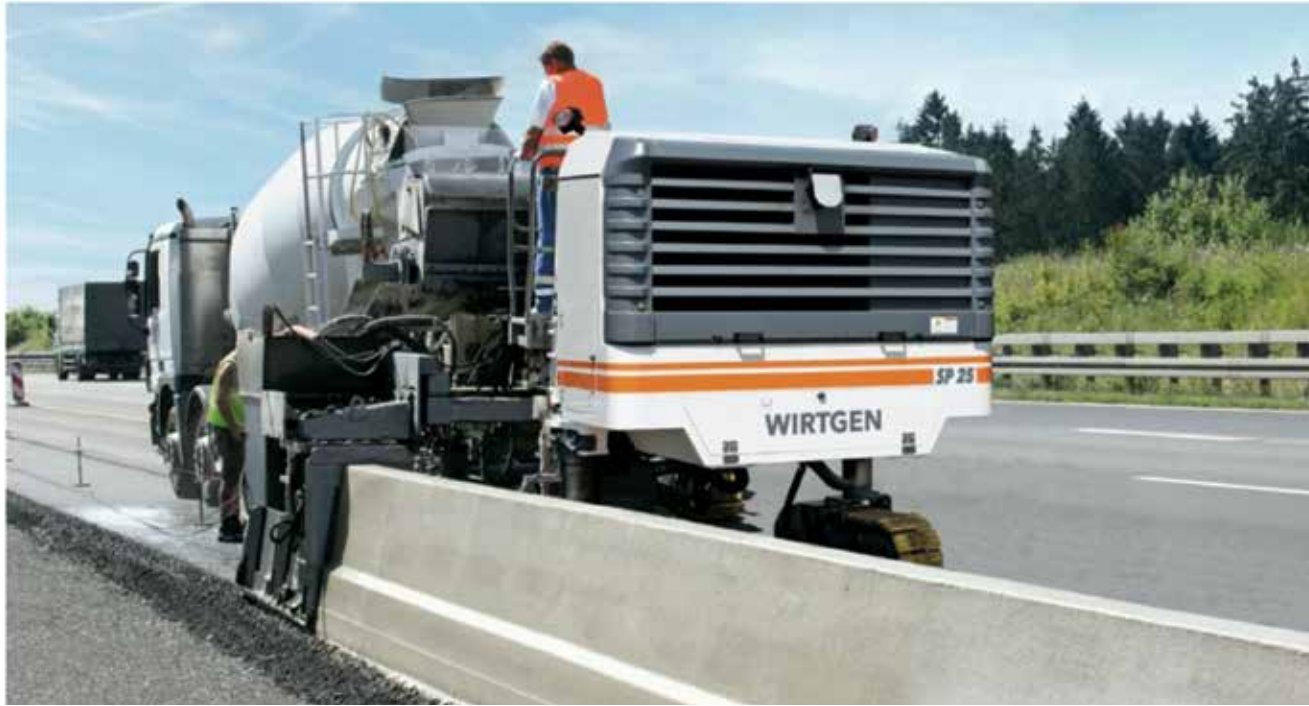
FOTO 5 - Barreras de hormigón in situ (Maquinaria Wirtgen).
