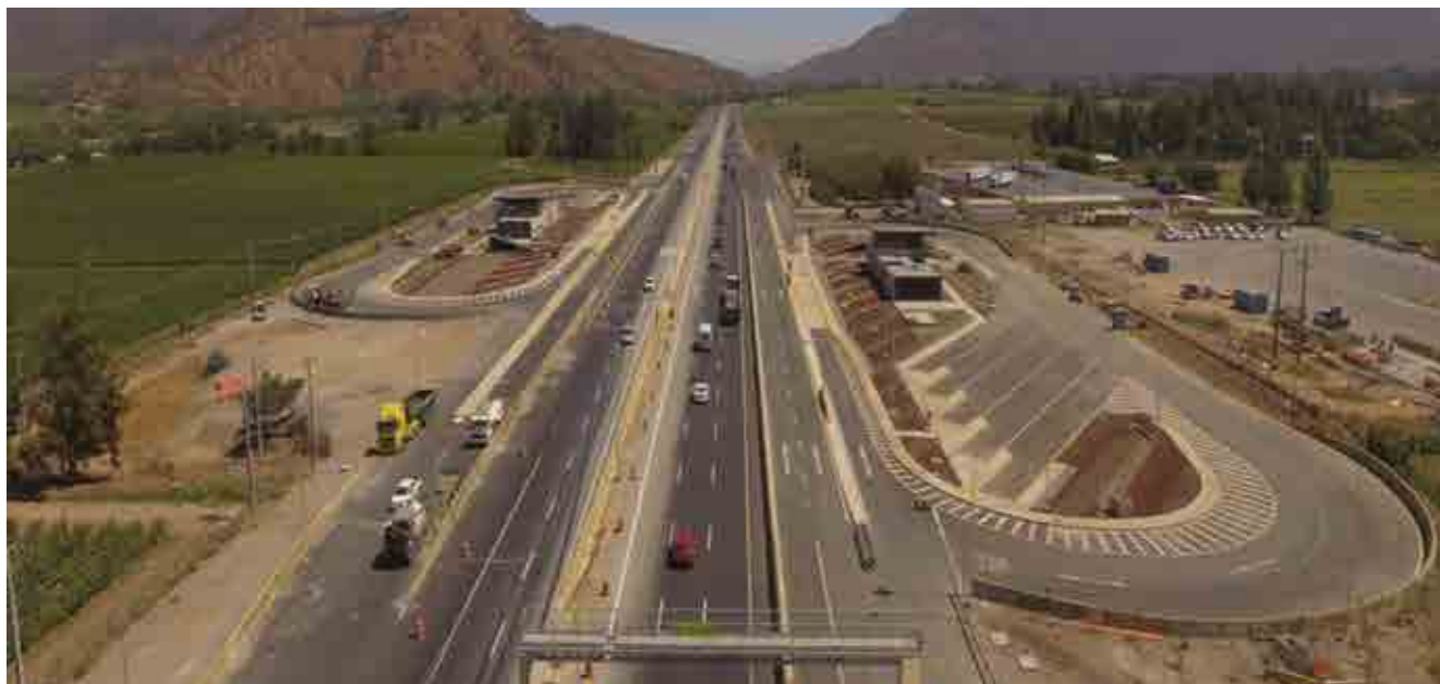
Plaza de Pesaje Fija con 2 Estaciones de Control.
