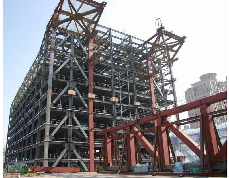
**BRB:** Buckling Restrained Brace/ Pilares de construcción restringidos por pandeo. Diseño Sísmico
