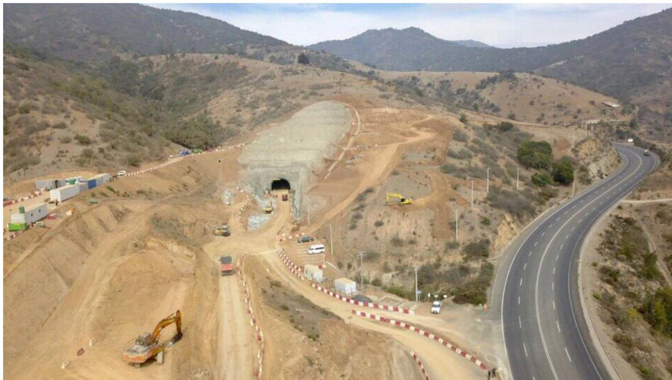
**Con la construcción de un nuevo túnel, el que además se unirá al ya existente, además de la ampliación de la calzada con dos pistas por sentido, esta obra brindará continuidad a la Ruta 5 en el tramo Los Vilos-Santiago.**
