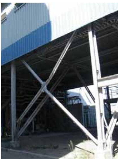
Figura 9. Pandeo de arriostramiento esbelto.
