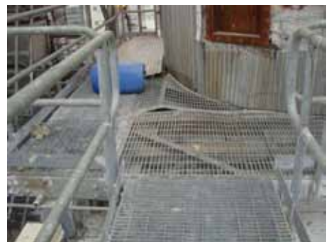
Figura 32. Choque debido a separación insuficiente. (a) Entre estructuras vecinas. (b) entre equipo y parrillas perimetrales.
