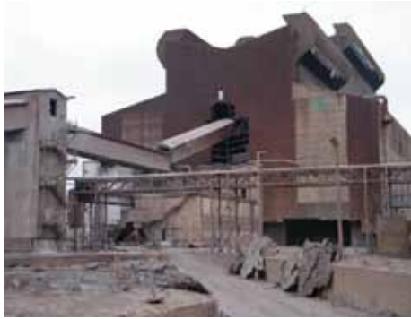
Figura 15. Colapso de galería de correa transportadora.
