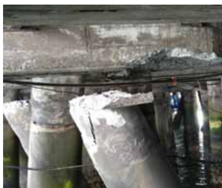
Figura 14. Corte de pilotes inclinados.
