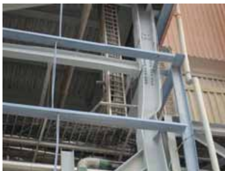
Figura 32. Choque debido a separación insuficiente. (a) Entre estructuras vecinas. (b) entre equipo y parrillas perimetrales.
