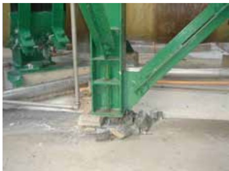
Figura 33. Pedestales fracturados por corte local.
