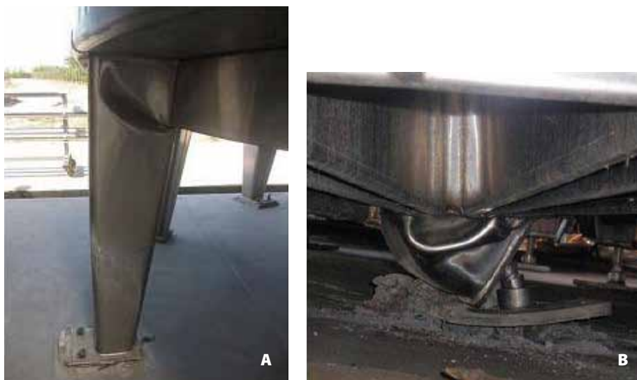
Figura 19. Pandeo de pata: (a) pata perimetral y (b) pata central.
