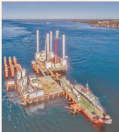
Descarga de materiales en Planta Cbb Ready Mix Roca Remolino.
