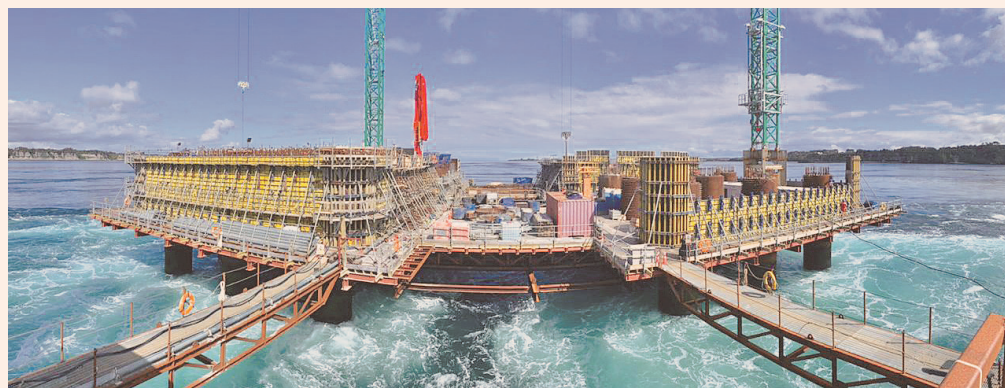
Doka, es una empresa austriaca fundada hace más de 150 años. En la foto, los encofrados DOKA instalados en los 4 Pilecap del pilón Central del Puente Chacao.
