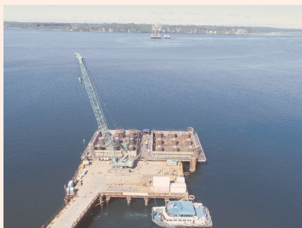
Zona Norte del Puente Chacao.
