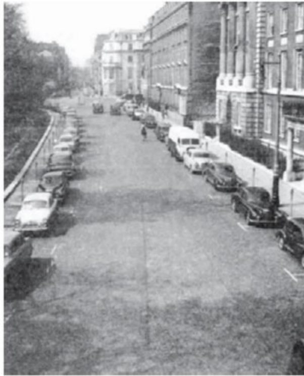
Meters (Se instalan parquímetros)
