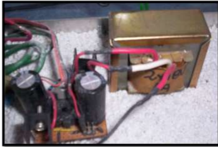
Figura C.11: Fuente de Alimentación continua de los circuitos auxiliares.
