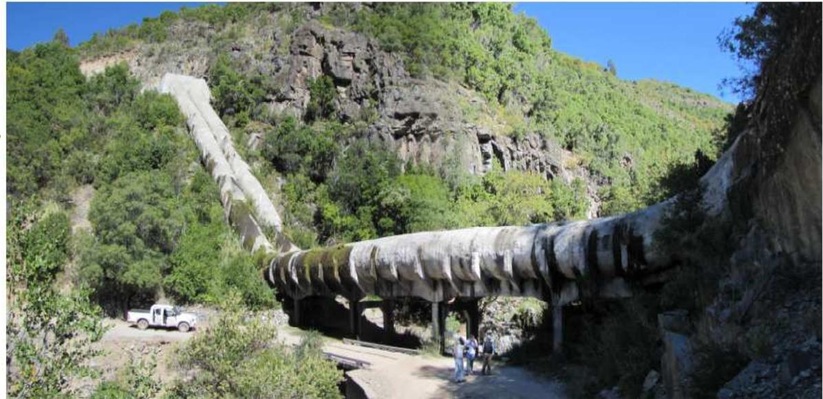
Foto N°3 Vista de un sifón (2 tubos de hormigón armado)
