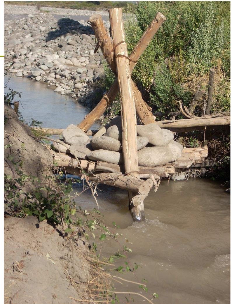
Estas estructuras normalmente no poseen compuertas de regulación y entra tanta agua como el canal es capaz de transportar.
