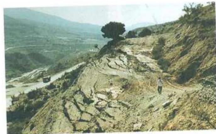
Fotografía E. Daños en autovías por deslizamientos (Granada)
