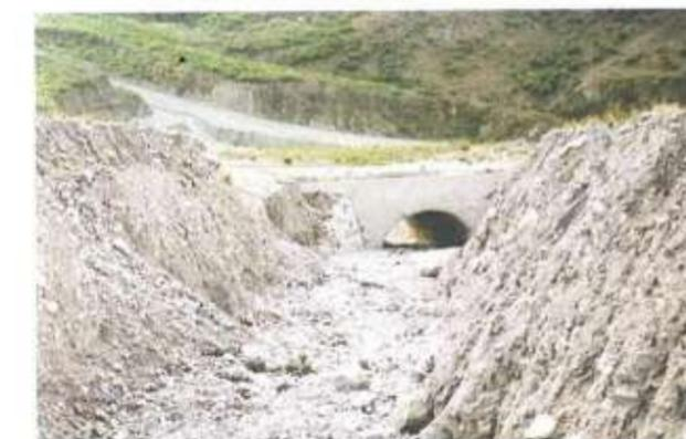
Fotografía D. Colmatación de cauce que rebasa la carretera y obliga a abrir un cauce artificial, Quebrada de Purmamarca, Argentina (foto M. Ferrer)
