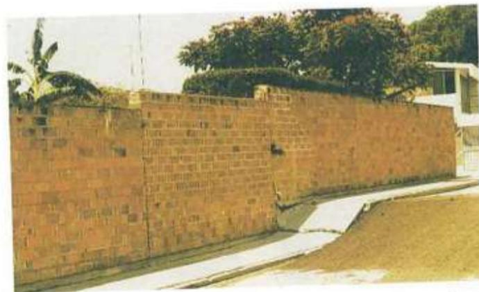
Fotografía F. Subsistencia por extracción de agua de pozos y a favor de fallas activas (Celaya, México)
