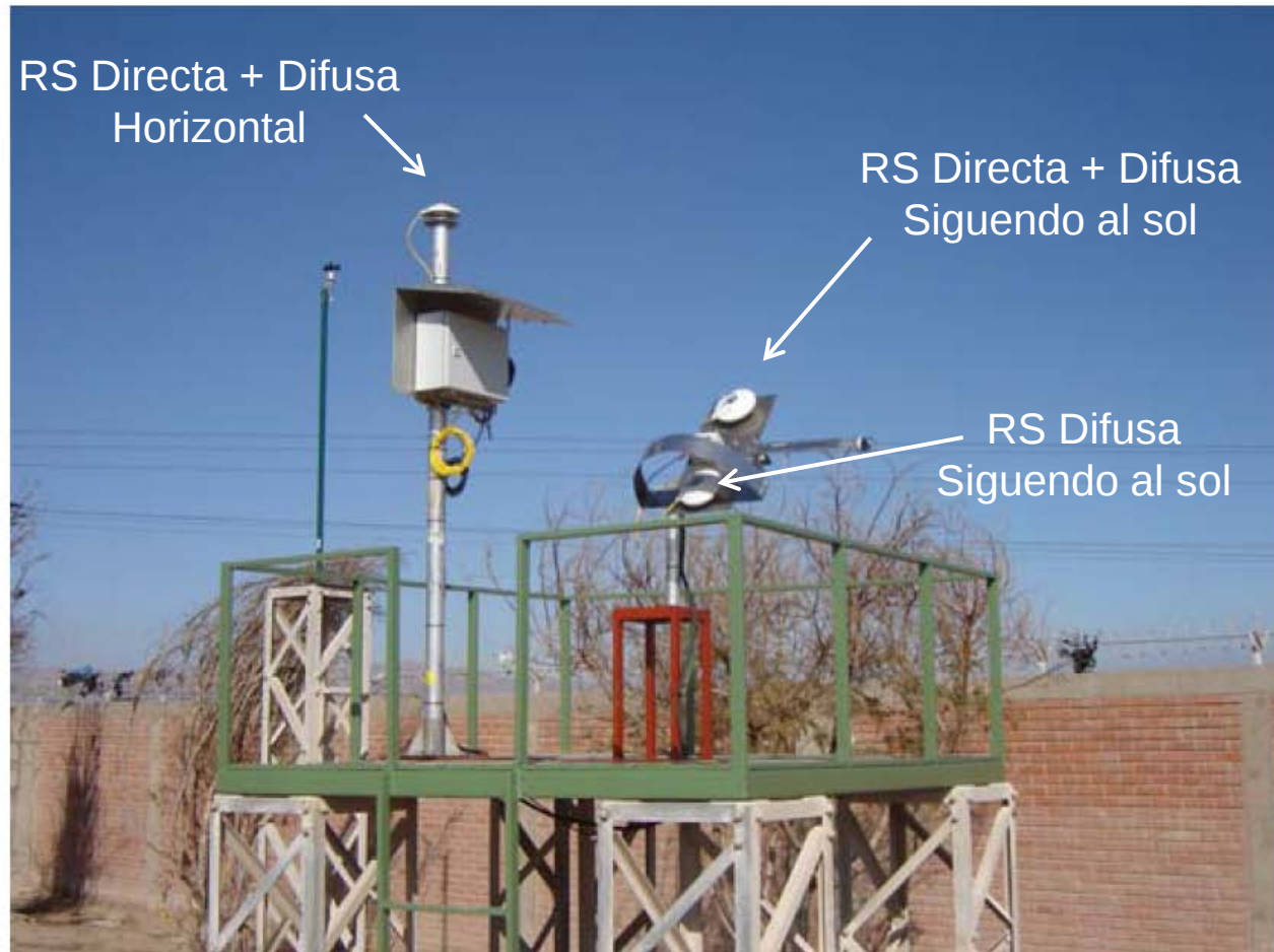
Figura 1: Vista completa de la estación
