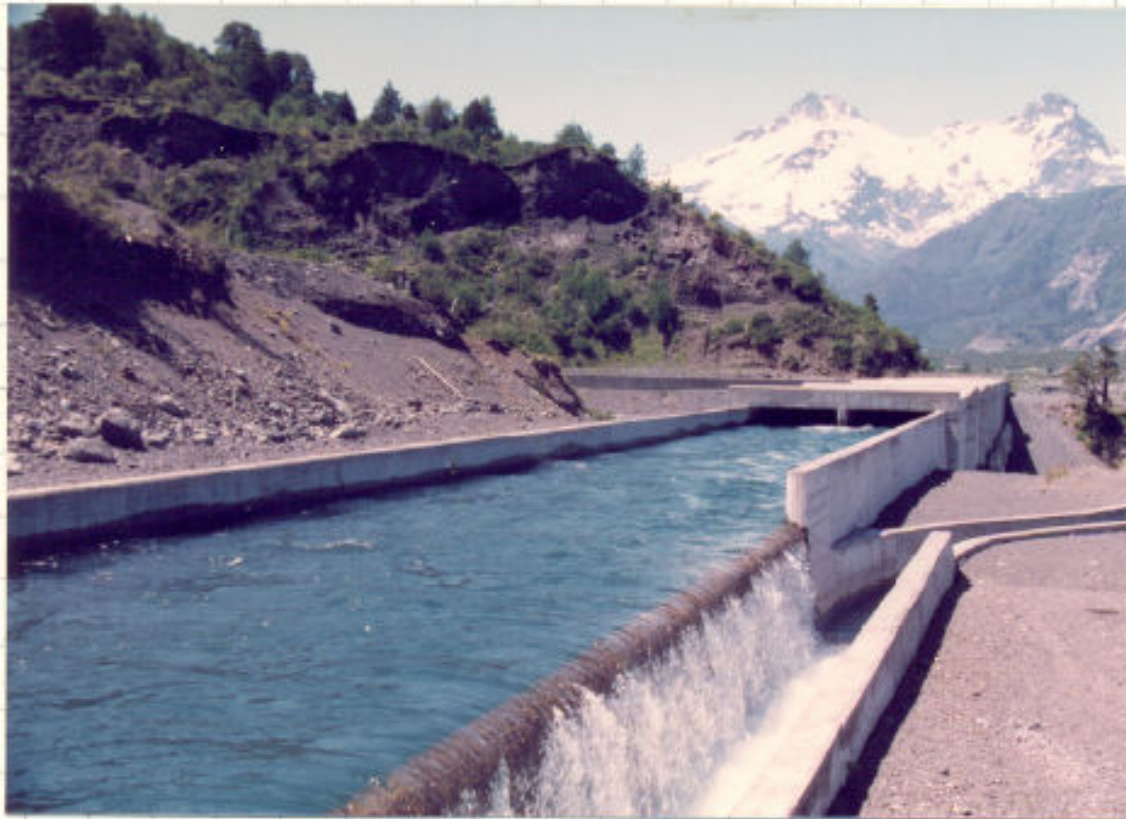
Vertedero lateral. Canal Laja. Central Antuco.
