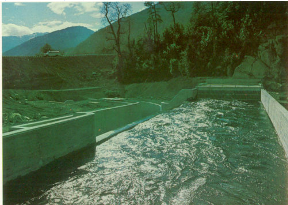
Sifón Polcura. Cámara de Entrada (Obra de seguridad)
