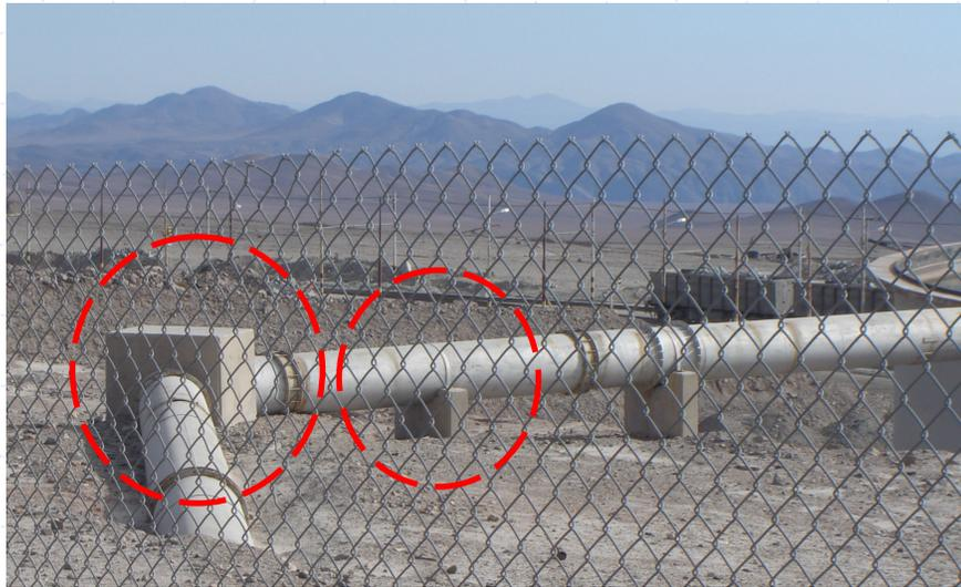
Los elementos de anclaje (sillas de apoyo y machones) deben dimensionarse (cálculo estructural) tomando en cuenta el tipo de material de la tubería y el tipo de suelo que en que se emplazará.
