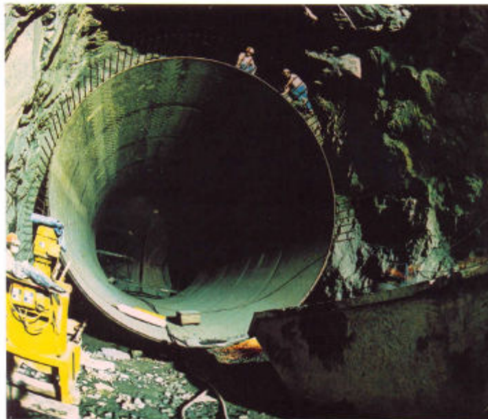
Central Colbón. Túnel blindado en construcción, montaje de la bifurcación.
