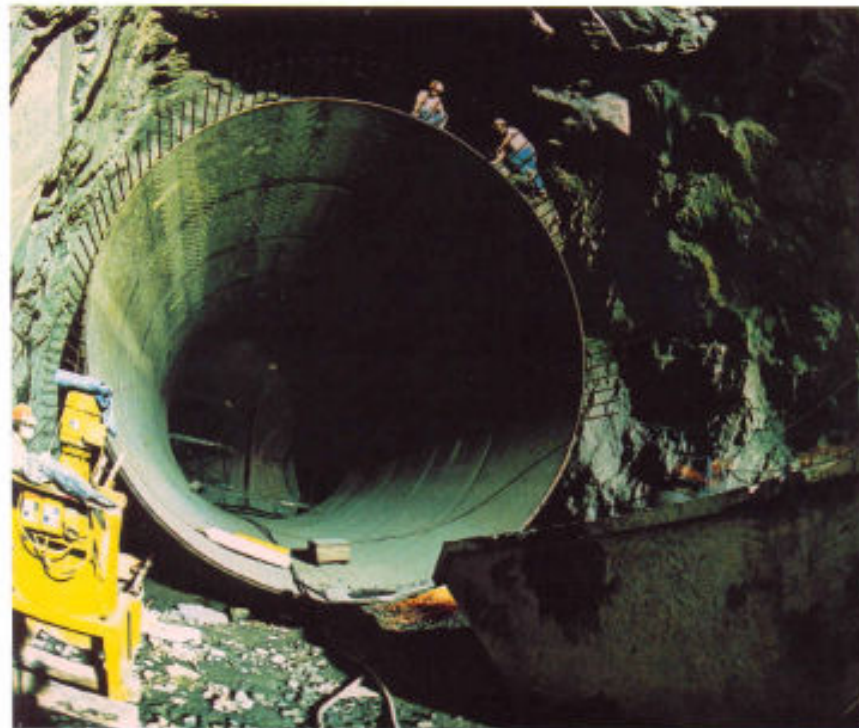
Central Colbún. Túnel blindado en construcción, montaje de la bifurcación.
