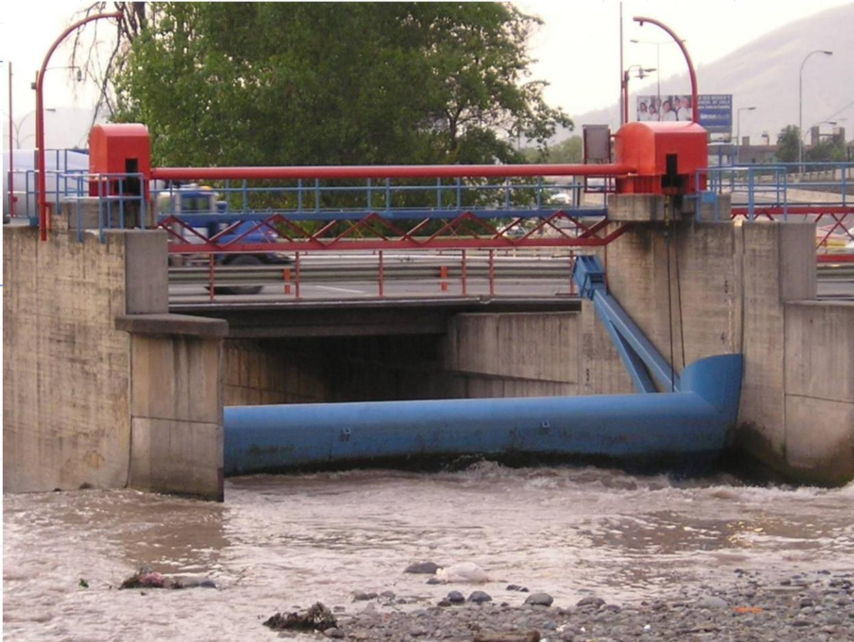
Compuerta radial móvil. Se acciona a través de motores ubicados en las casetas naranjas.
