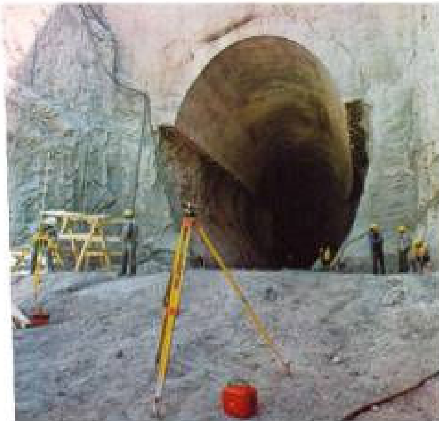
Túnel de desviación en construcción. Boca de entrada.
