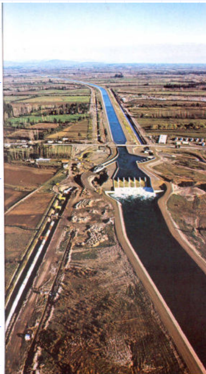
Canal de devolución y su obra de entrega al río Maule; a su derecha el canal de restitución del riego, a la izquierda la entrega al sifón Maule.
