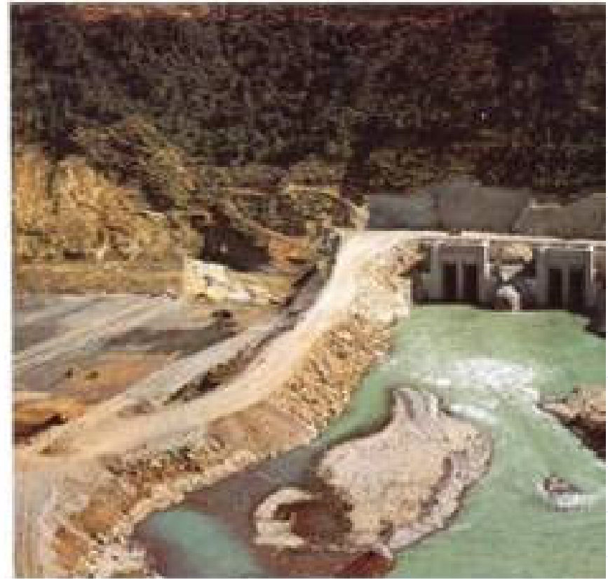
Túneles de desviación. Bocas de entrada.
