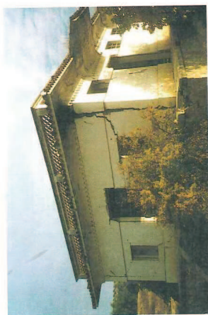
Figura 2.93 Estación agrietada por la expansión de arcillas. Jaén (foto C. Oteo).
