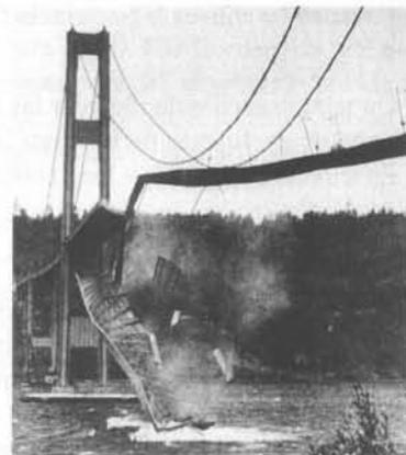
El viento turbulento produjo ondas estacionarias en el puente colgante de Tacoma Narrows, produciendo su derrumbamiento el 7 de noviembre de 1940, sólo cuatro meses después de haber sido abierto al tráfico.
