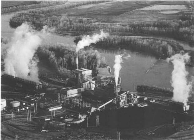
En esta central de producción de energía eléctrica de Kansas (EE.UU), la energía química almacenada en el carbón fósil (montículo negro que aparece en la fotografía en la parte inferior derecha) es liberada por combustión para producir vapor de agua; este vapor impulsa las turbinas para generar electricidad. El calor no aprovechado se disipa en torres de refrigeración.
