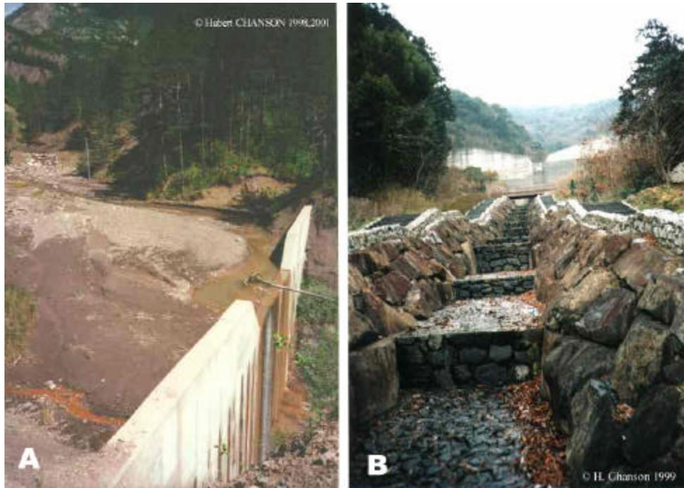
**Fig. 2.10** Ejemplo de presas contenedoras. A) Presa llena de sedimentos; B) Vista del canal escalonado aguas abajo de la presa (Chanson, 2001)
