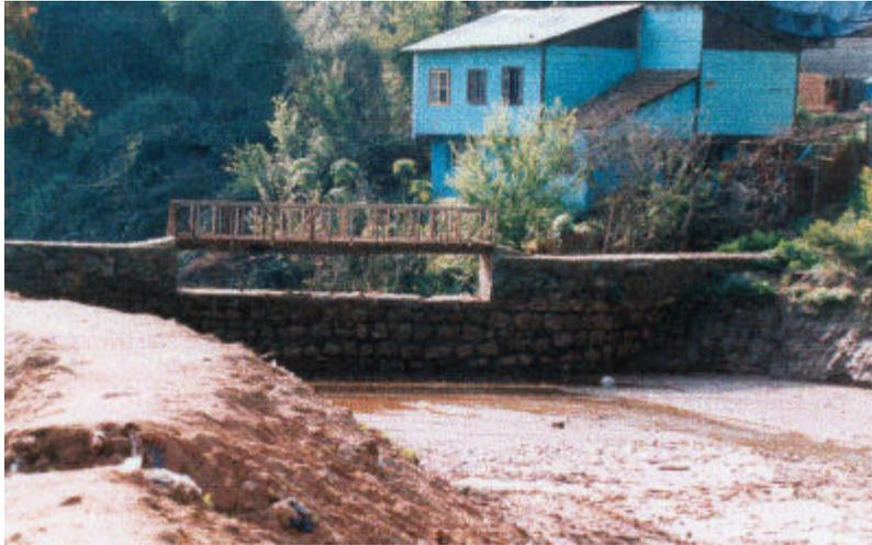
**Fig. 3.1** Muro de mampostería instalado en el eje de descarga de una quebrada (calle Francia), en el casco urbano de la ciudad de Valparaíso. La obra fue construida en el año 1940 (Hauser, 2004).
