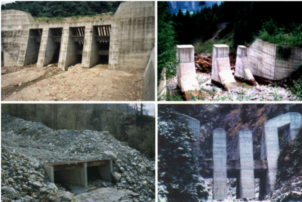
**Fig. 2.21** Obras disipadoras de energía (Fiebiger, 2003)
