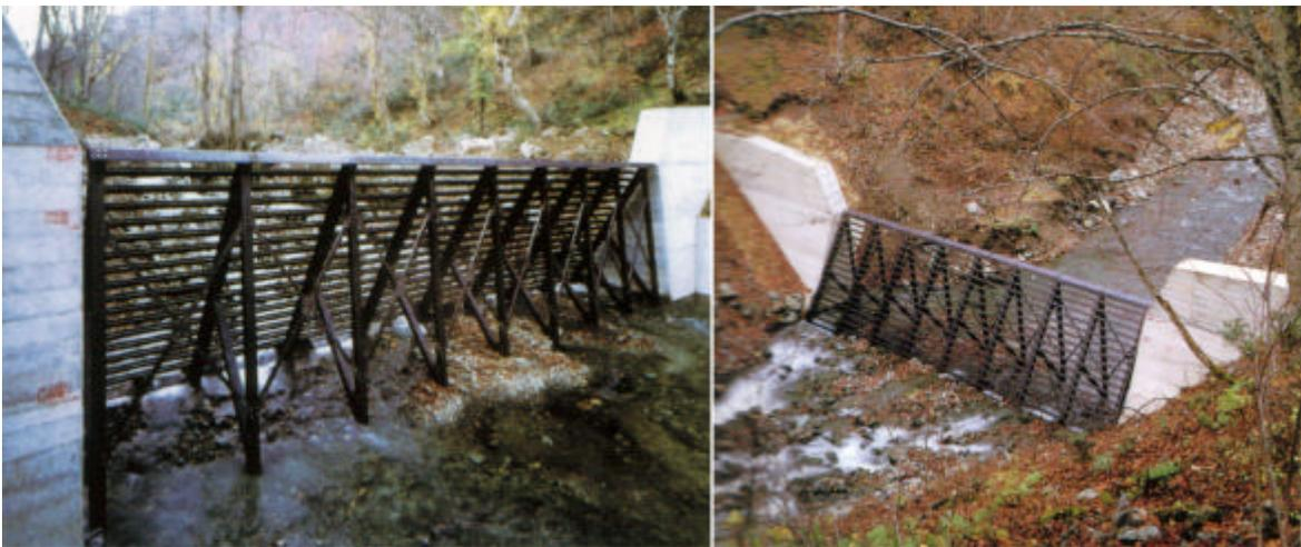
**Fig. 2.16** Presa de apertura horizontal (*beam-dam*) (Mizuyama, 2003).
