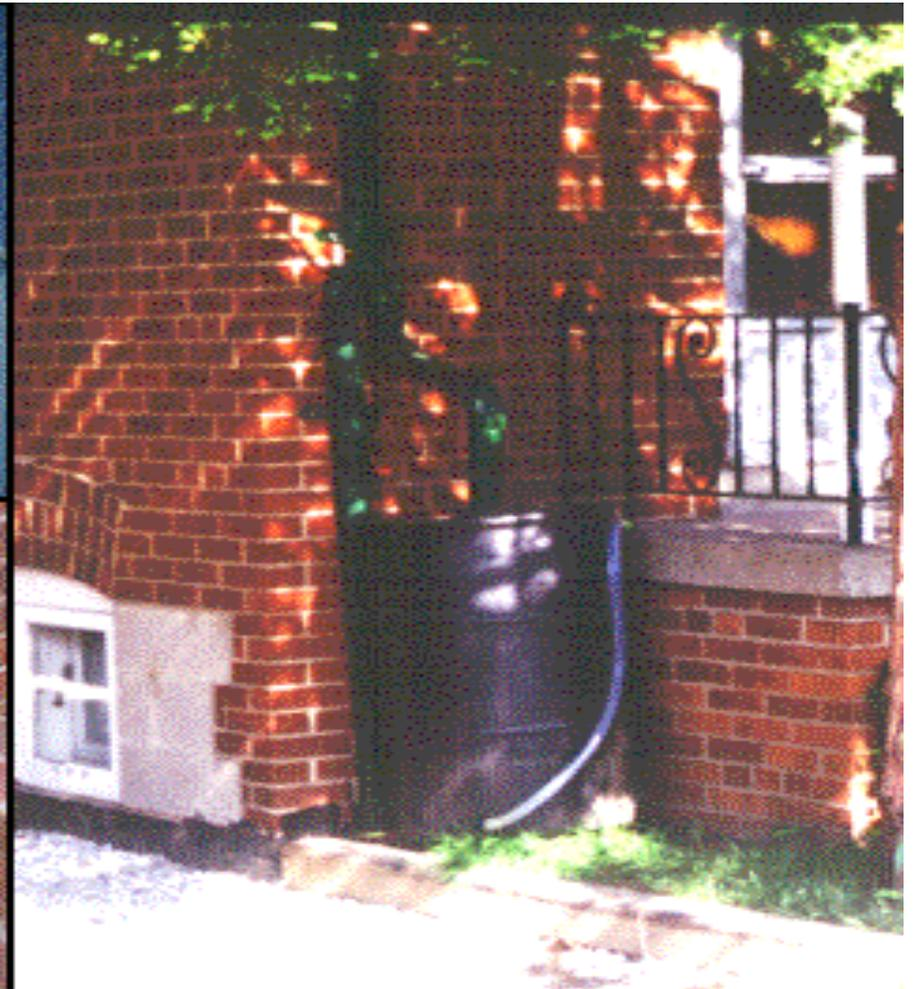
**Redirigir el excedente de los techos hacia superficies permeables antes de alcanzar superficies pavimentadas puede disminuir la escorrentía y los agentes contaminadores por lluvia de tal modo que se reducen los impactos hacia aguas abajo. Una alternativa a la salida de drenaje del tejado es vaciar directamente en barriles, que pueden almacenar el agua de lluvia para un uso posterior en el riego de los jardines, patios o para las plantas de la casa.**
