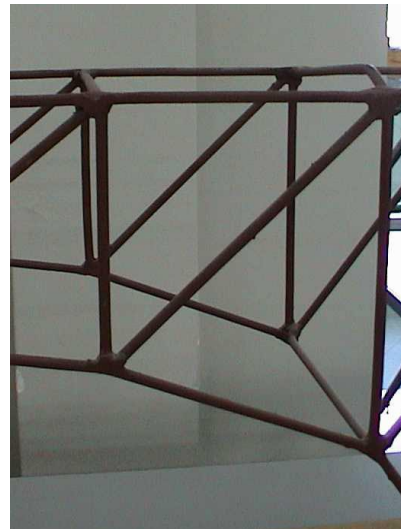
Uniones Rotuladas Los elementos soldados formar una rotula
