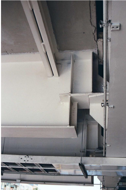
Apoyo Deslizante rotulado Nótese la placa en la cual descansa la viga.
