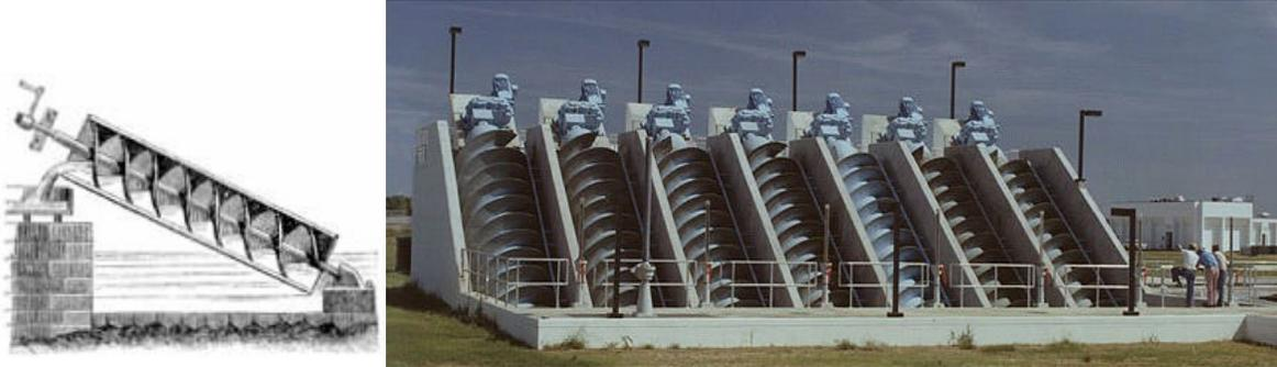
Fig. 1.7. Tornillo de Arquímedes. La imagen de la derecha corresponde al sistema de utilizado en una planta de tratamiento de agua en Memphis. La planta de tratamiento de La Farfana emplea un sistema similar, pero se encuentra cubierto, por lo que no se aprecia el tornillo sin fin.
