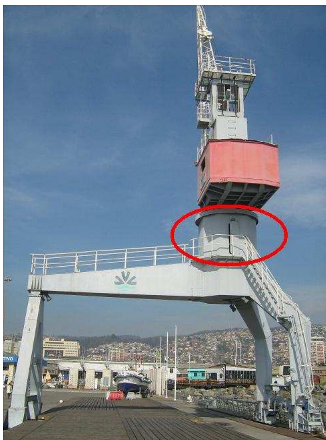
Figura n°17: Base de giro de la grúa.
