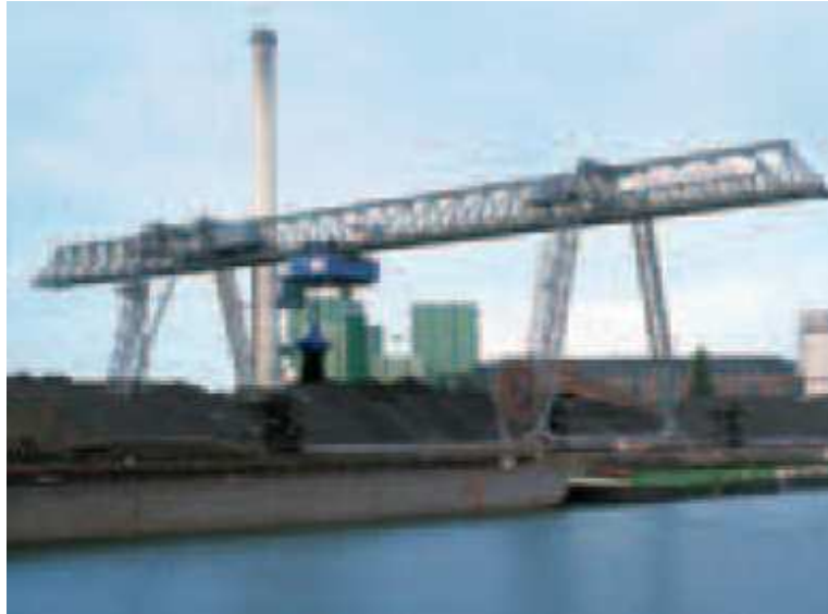
Figura n°9: Grúa tipo pórtico.
