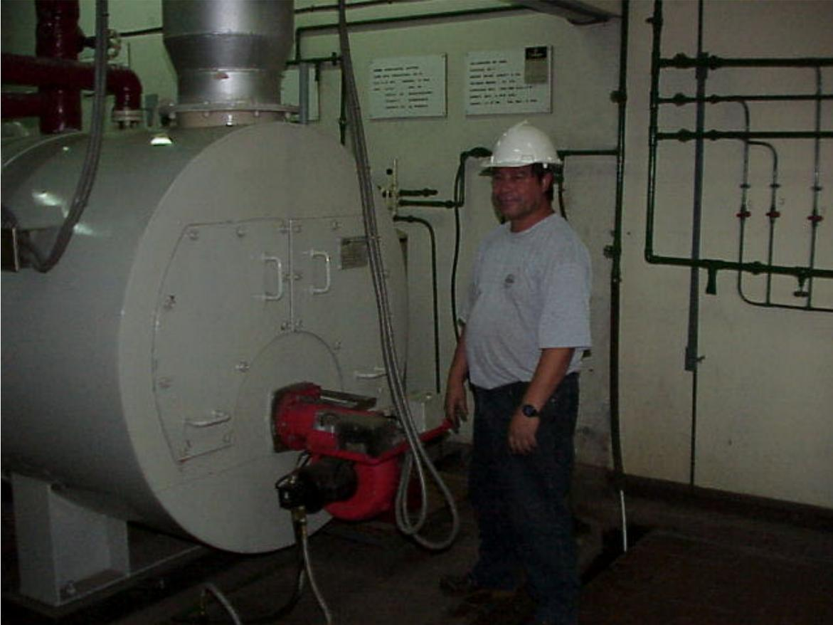
El equipo corresponde a una caldera (autoclave) generador de vapor tipo horizontal, piro-tubular (2 pasos), fabricada en Chile por H. Briones, modelo PowerPak (PPK) 1/40, N° 1, año de fabricación 1982.
