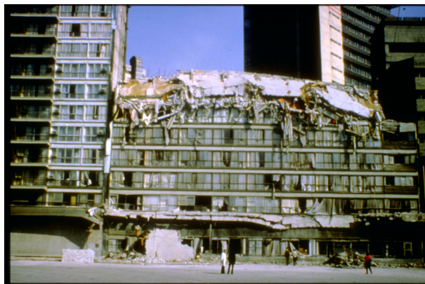
Figura 2: Derrumbe del Hotel Continental ocurrido durante el terremoto de 1985 en ciudad de México. Este edificio entró en resonancia con la frecuencia de forzaje del temblor, y sus pisos superiores colapsaron. Otros edificios contiguos, más altos o más bajos, no sufrieron los mismos daños que este hotel.
