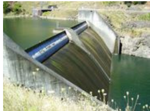
Figura 1: Vertedero de una presa
