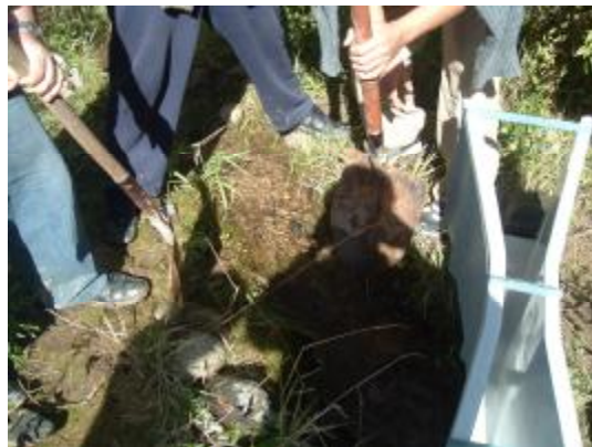
Figura 3.4: Mejoramiento de la zona a aforar
