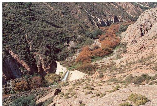
[La menor pendiente del aterramiento formado disminuye la velocidad del agua y su capacidad de erosión. \(Dique en el río Válor, Granada\).](#)
