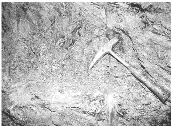
Figura 20 : Apariencia del esquisto ateniense, de muy mala calidad geotécnica, en la frente de la galería gemela que se muestra en Figura 19.
