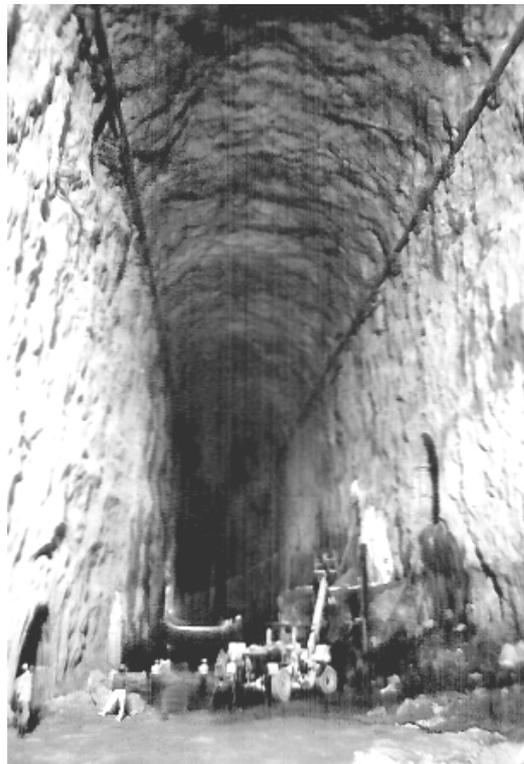
Figura 14 : Caverna de máquinas parcialmente excavada, con una luz de 20 m y 42,5 m de altura, del Proyecto Hidroeléctrico Nathpa Jhakri en Himachel, India. La caverna se ubica a unos 300 m de profundidad.
