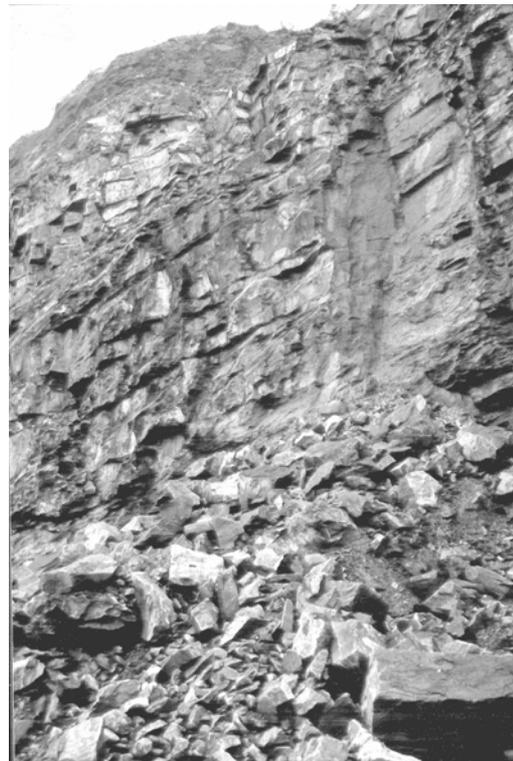
Figura 23 : Falla controlada estructuralmente en la cara de un banco empinado, en un macizo rocoso fuertemente fracturado.
