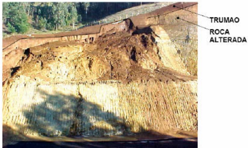
Fig. 1 Deslizamiento en el Corte Poniente PK 13+200.
