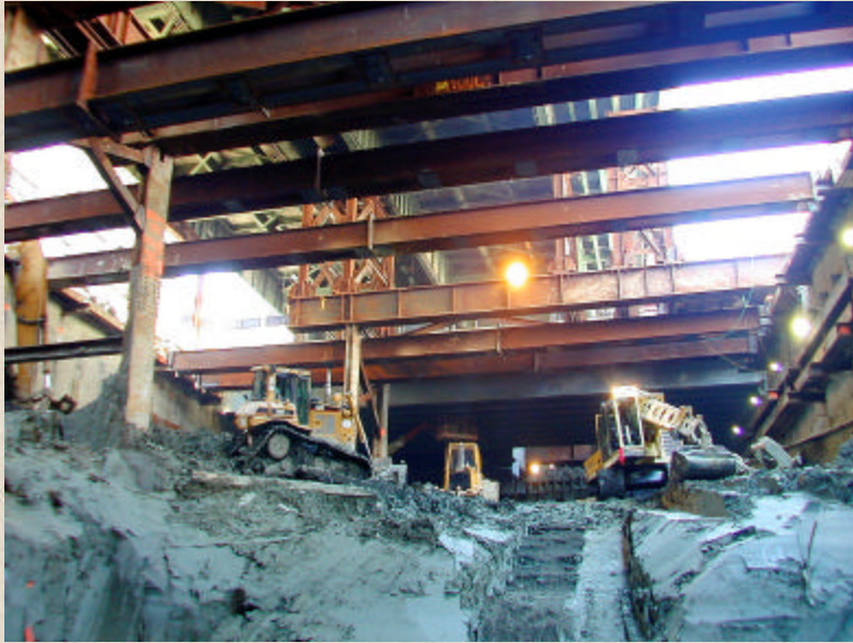
Construyendo el túnel bajo la vía elevada
