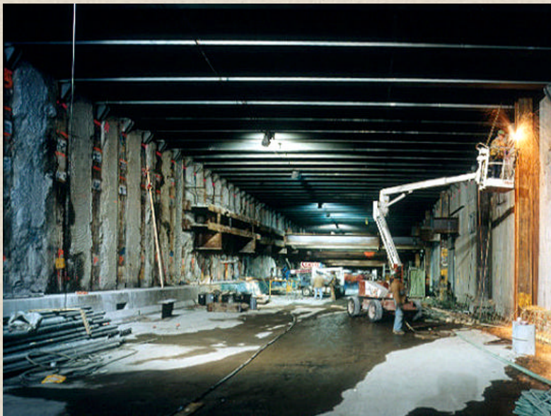
Construyendo el túnel bajo la vía elevada
