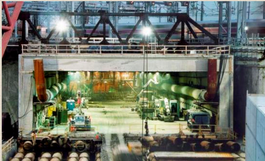
Túnel bajo la línea del tren
