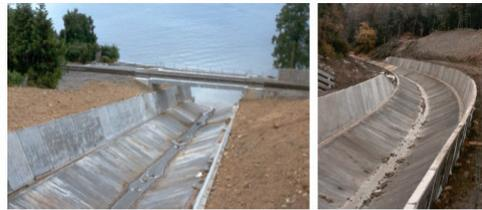
IN Fig. 2.27 Canales conductores de flujos detríticos.
