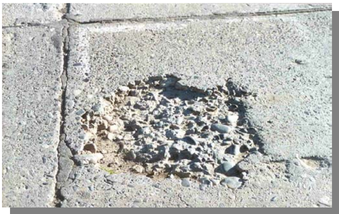
Foto N°15 Bache Abierto en Hormigón
