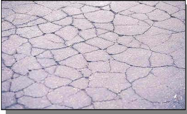
Foto N°2 Grietas tipo piel de cocodrilo
