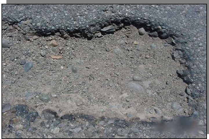
Foto N°7 Bache Abierto en Asfalto
