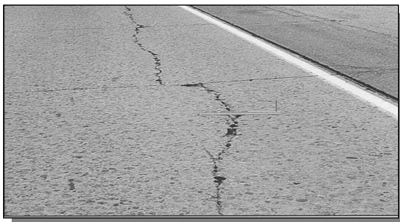
Foto N°9 Grieta Longitudinal
