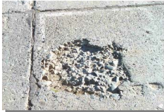
Foto N°15 Bache Abierto en Hormigón
