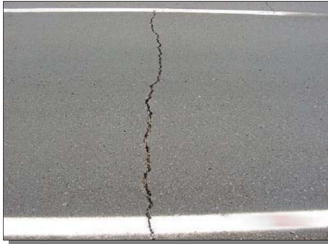
Foto N°3 Agrietamiento Térmico
