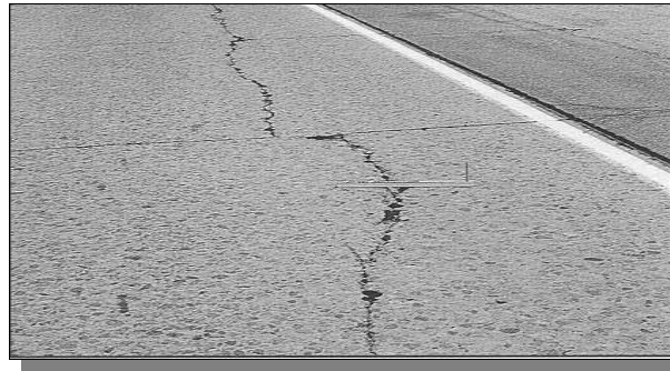
Foto N°9 Grieta Longitudinal
