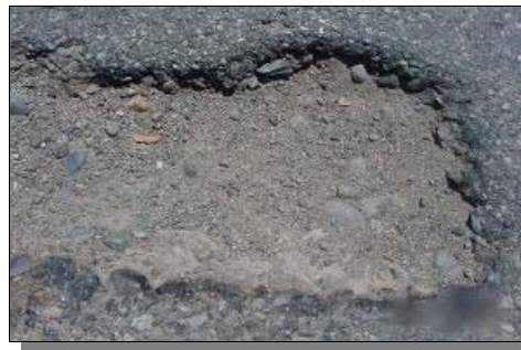
Foto N°7 Bache Abierto en Asfalto
