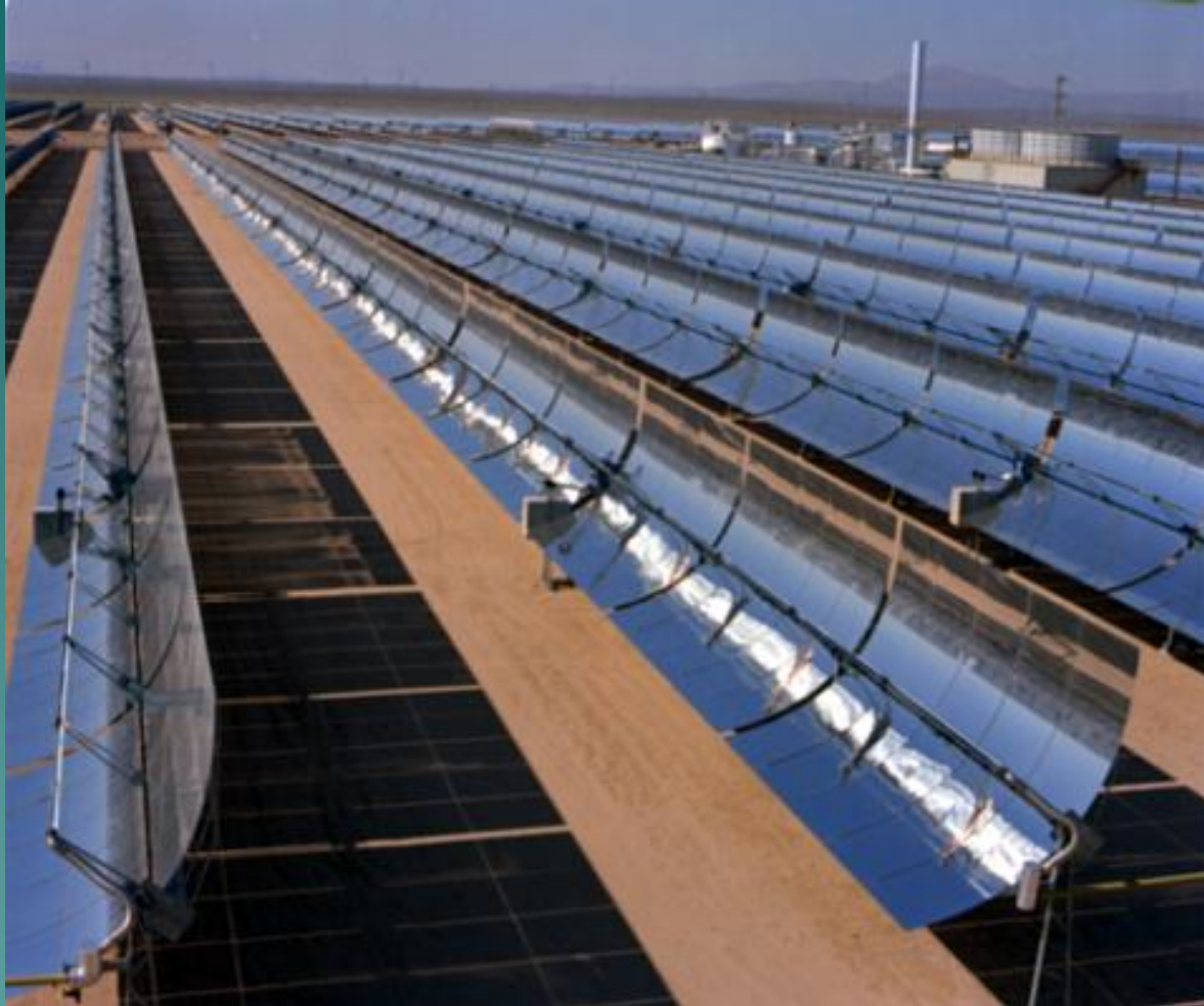
Planta SEGS en California: híbrido solar-gas natural
