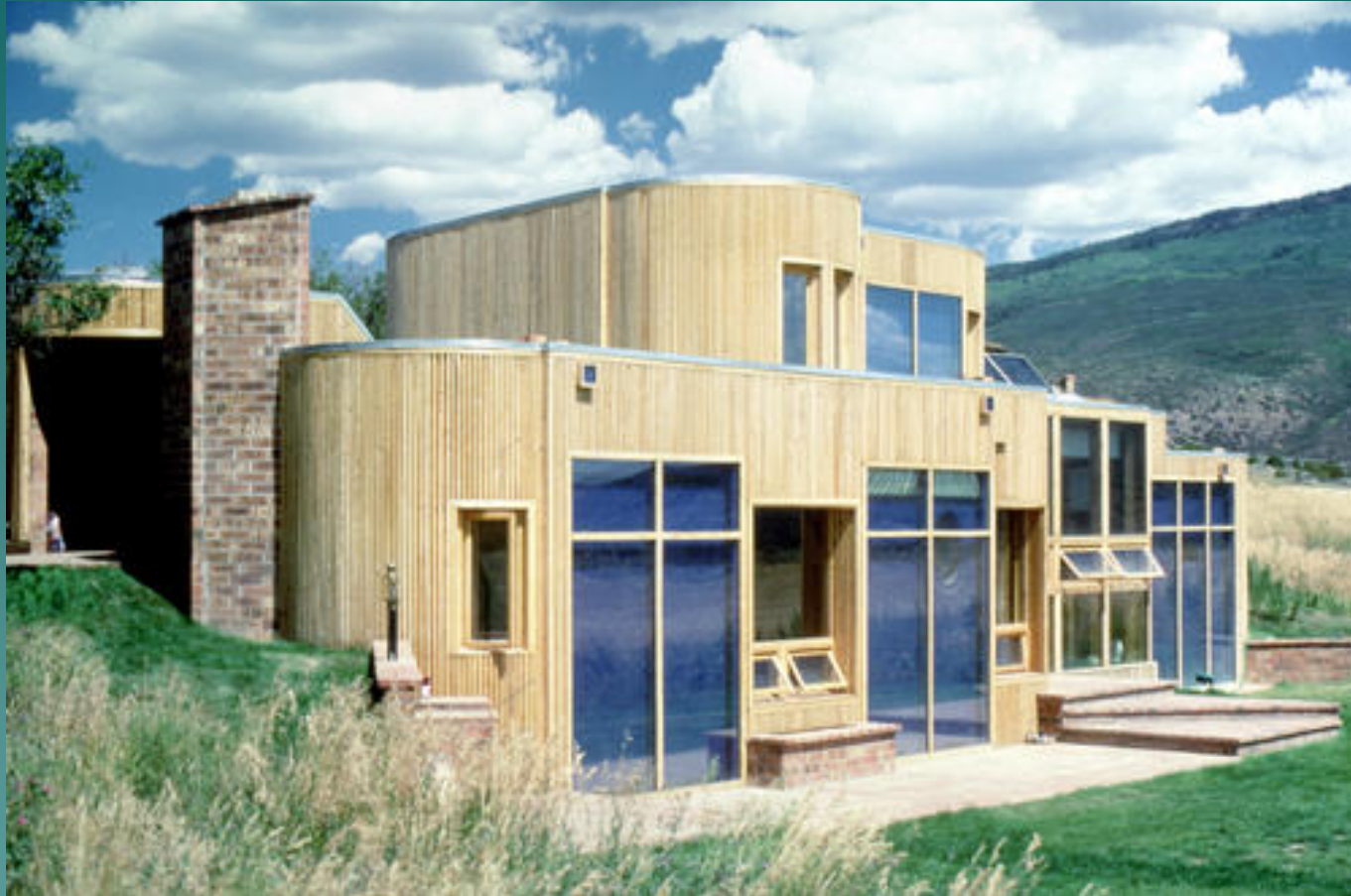
Casa con sistema de calefacción solar en base a Muro Trombe
