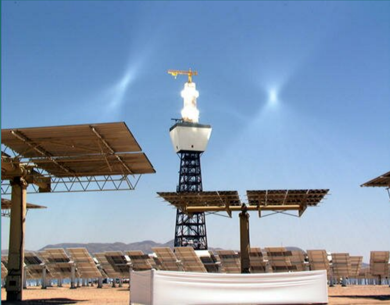
Sistema de Torre Central 10 MW potencia
