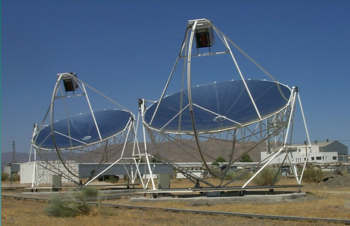
Sistema Stirling de Motores de 50 kW (Euro dish)
