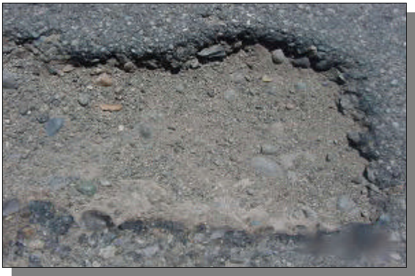
Foto N°7 Bache Abierto en Asfalto
