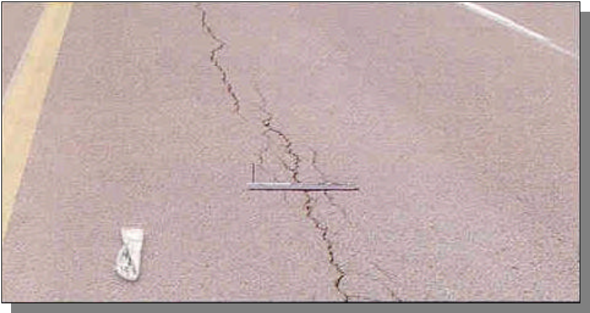
Foto N°1 Agrietamiento Estructural Lineal
