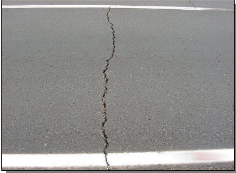
Foto N°3 Agrietamiento Térmico
