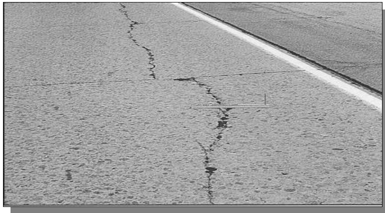
Foto N°9 Grieta Longitudinal
