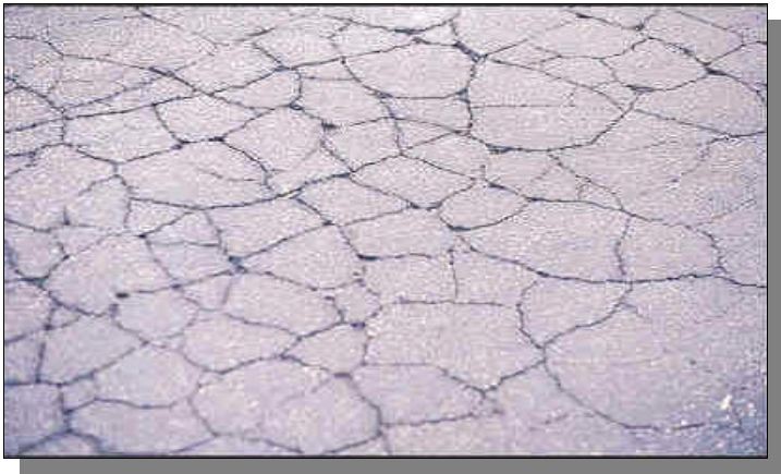
Foto N°2 Agrietamiento tipo piel de cocodrilo
