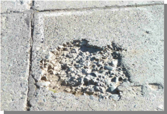
Foto N°15 Bache Abierto en Hormigón
