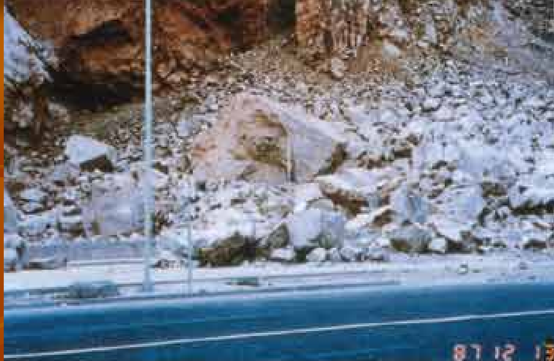
Desprendimiento rocoso inducido por el sismo del 8 de Agosto de 1987, en el flanco norte del Morro de Arica, Región I. Un operador porta una mira de 4 mts de alto, para destacar un bloque de 280 toneladas (Foto de Ingeniería y Geotécnica Ltda)
