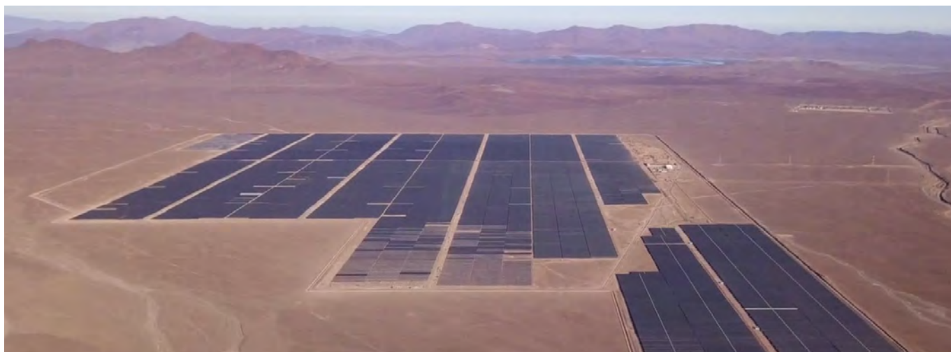
Planta Fotovoltaica El Romero Solar, cuya potencia máxima es de 246,6 (MWp) -196 MW nominales. Fuente: Acciona Chile.
