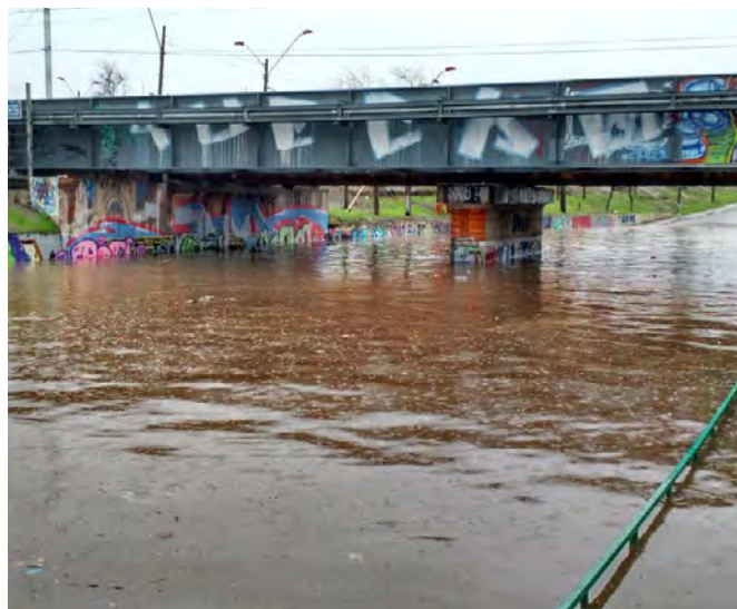
Inundación Paso Bajo Nivel Callejón Lo Ovalle. Fuente: CNN Chile. En https://twitter.com/CNNChile/status/629320110742896641/photo/3
