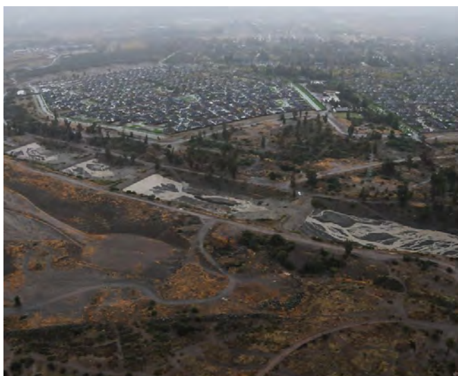
Piscinas Aluvionales de las quebradas de San Ramón y Macul. Fuente: Ministerio de Obras Públicas (2016) En https://twitter.com/mop_chile/status/721764201891545088/photo/1 y photo/2
