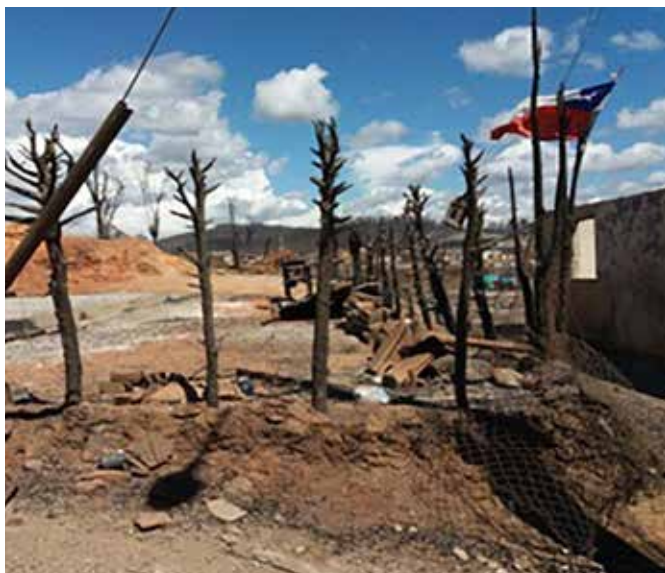
Sistema Agua Potable Santa Olga. Fuente: Dirección de Obras Hidráulicas MOP Febrero 2017
