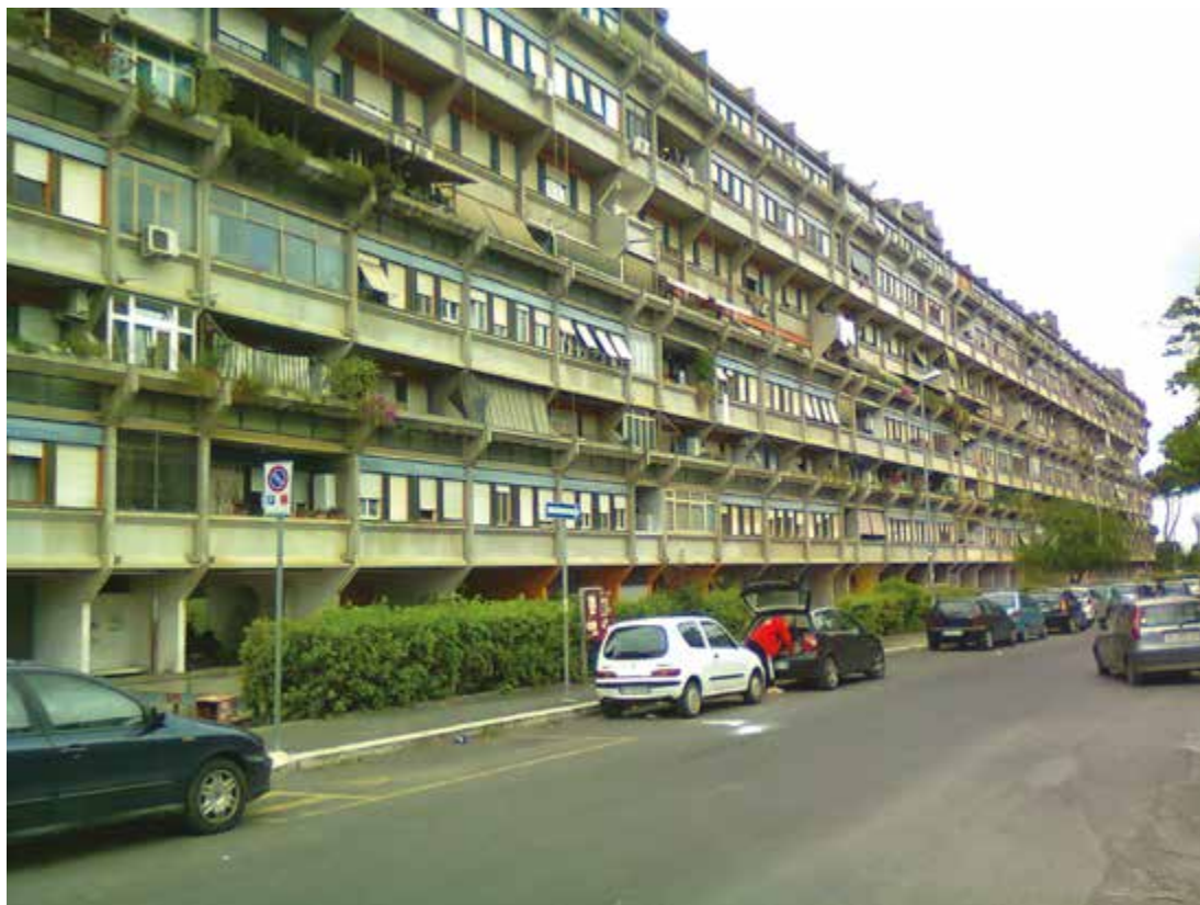
Figure 3. Logements de l'ATER, Viale Giorgio Morandi (© Google Earth).
